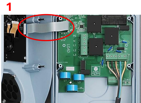
Slika 40: Spajanje flat kabela
