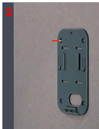
Slika 2: Označavanje rupa
