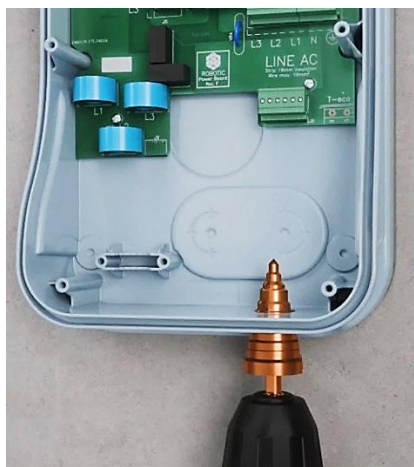
Slika 20: Bušenje rupe za kabel za napajanje
