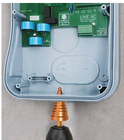
Slika 22: Bušenje rupe za kabel CT-a
